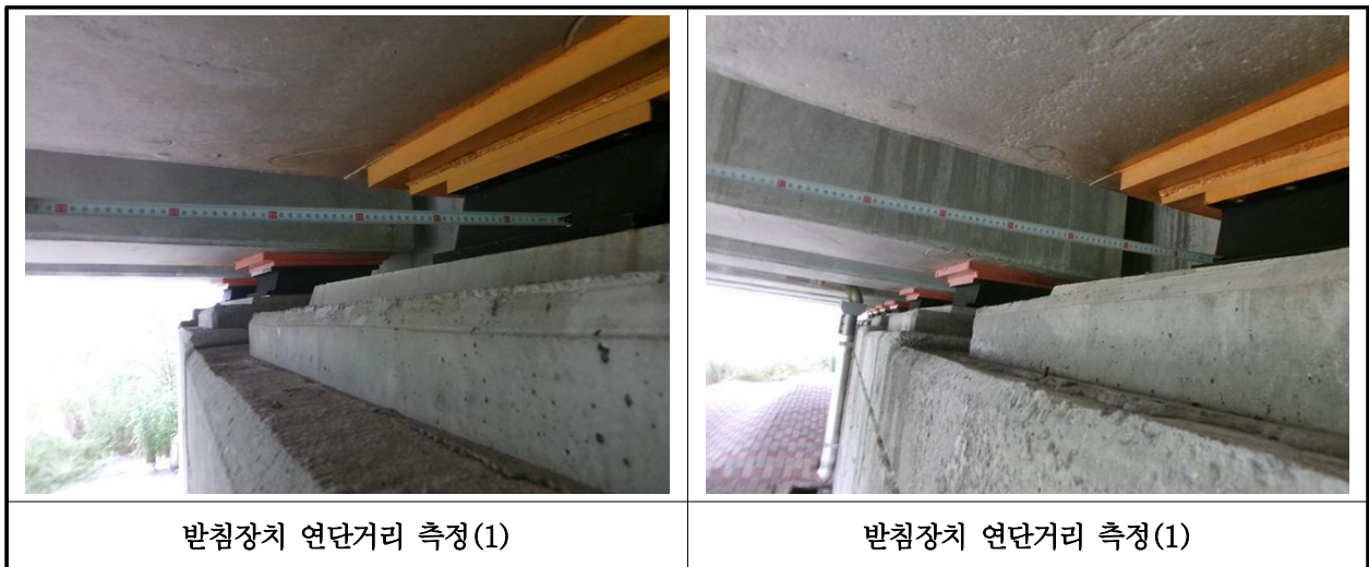
【사진 32.3.14】 교량받침장치 연단거리측정
