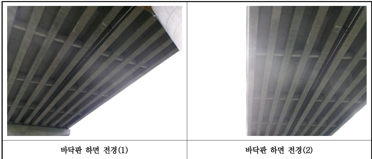
【사진 32.3.2】 바닥판하면 전경
