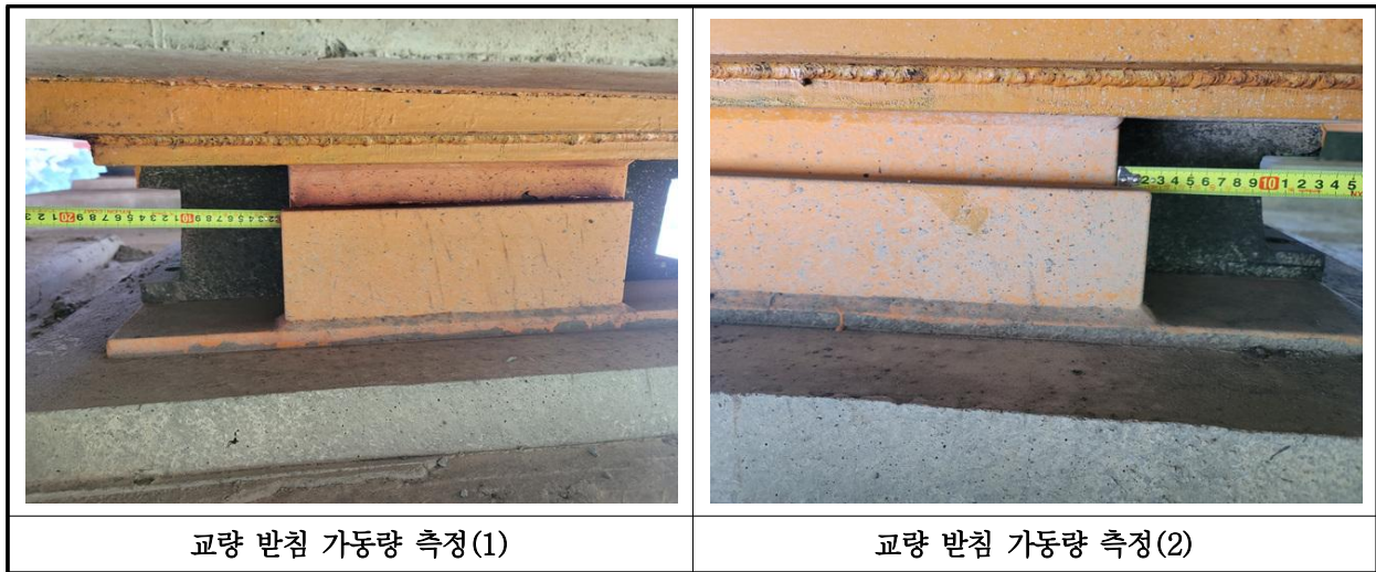
【사진 32.3.15】 교량받침 이동량 측정
