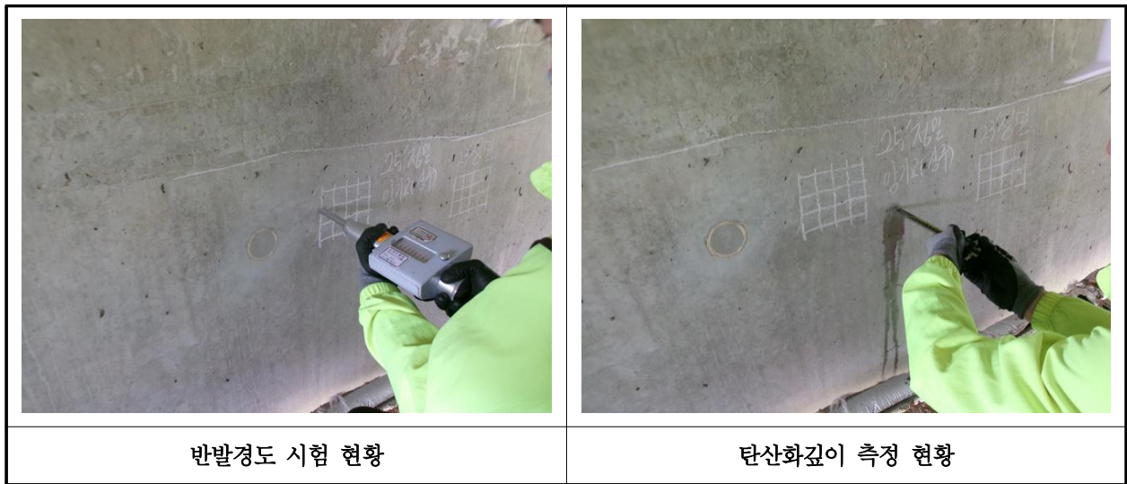
【사진 32.4.1】 콘크리트 내구성조사 현황
