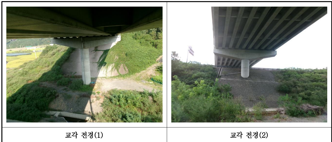
【사진 32.3.10】 교각 전경
