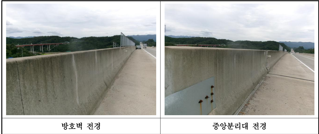
【사진 32.3.23】 방호벽 및 중앙분리대 전경
