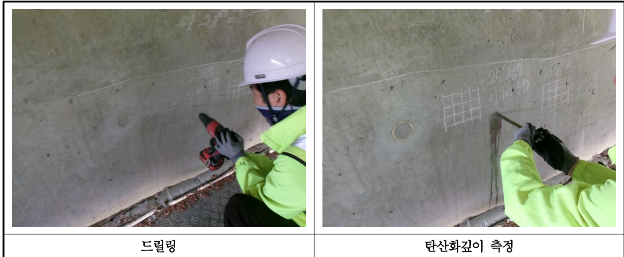
【사진 32.4.3】 탄산화 깊이 측정 현장사진
