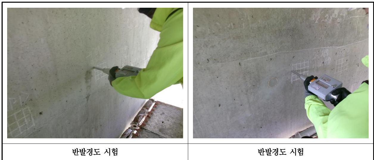
【사진 32.4.2】 반발경도시험 현장사진
