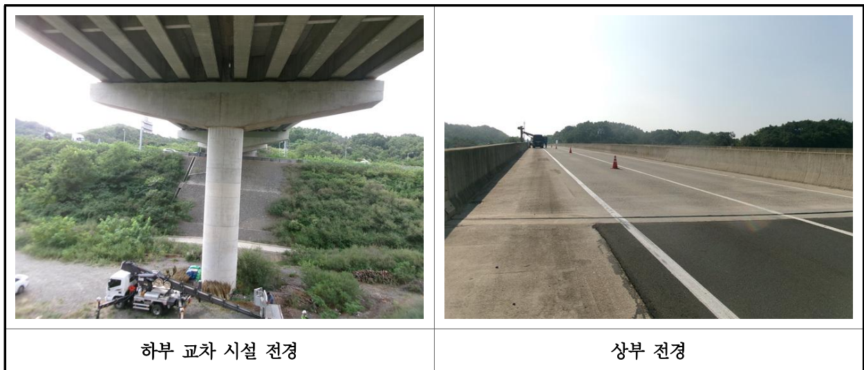
【사진 32.2.1】 부재 현장측정 전경
