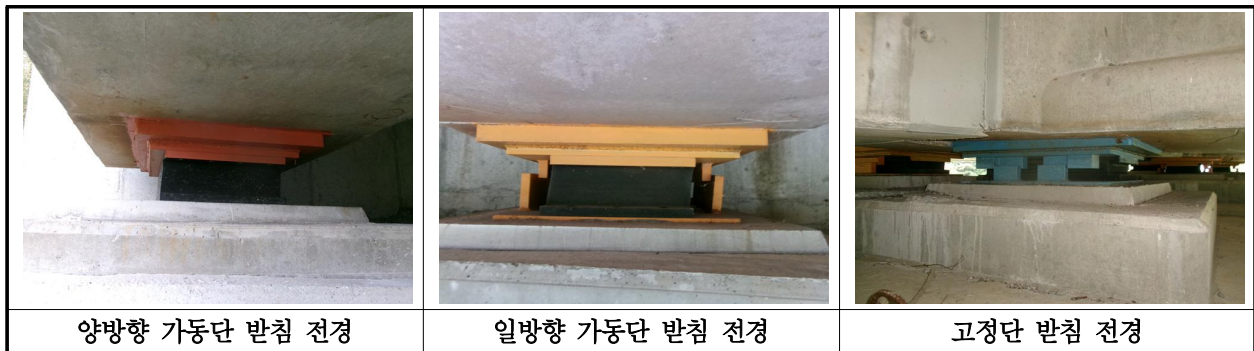
【사진 32.3.12】 교량받침 전경
