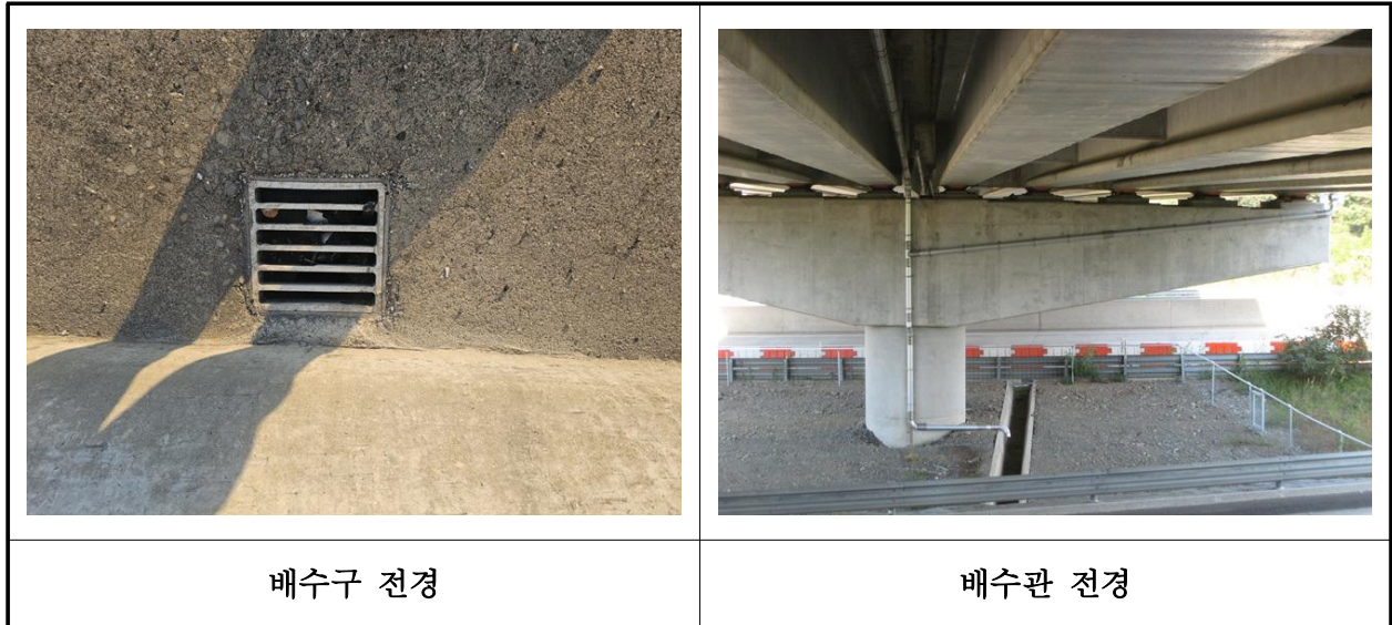
【사진 32.3.21】 배수시설 전경
