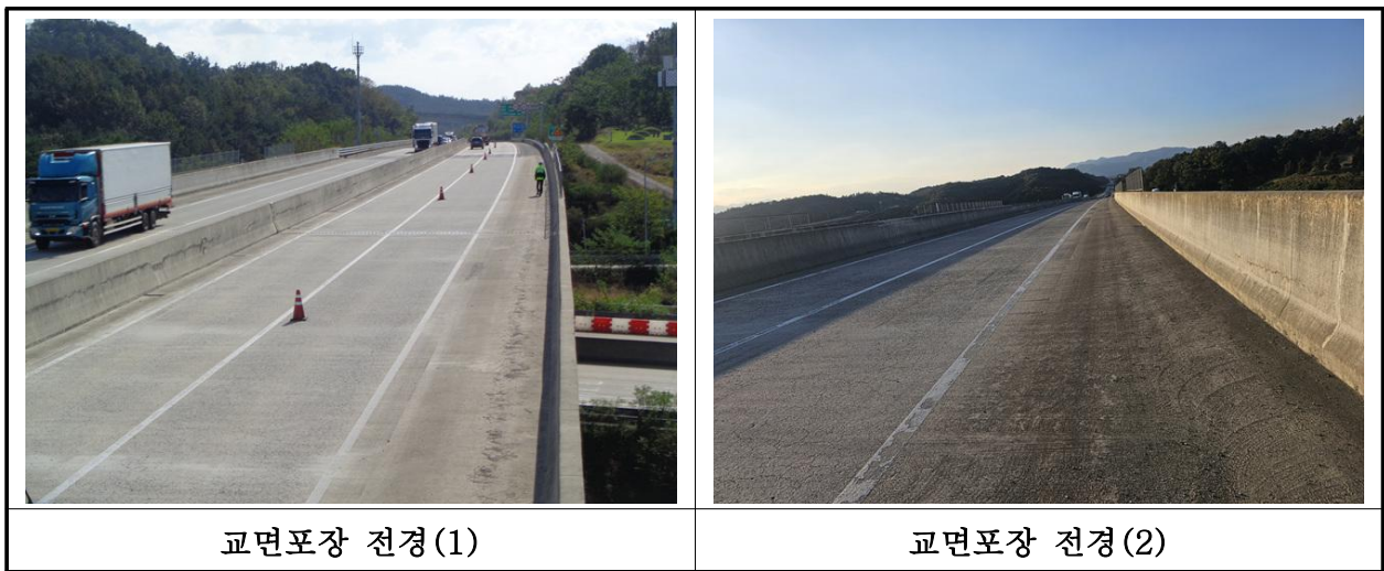
【사진 32.3.19】 교면포장 전경
